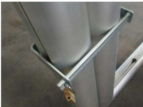
3. Durch Einhängen eines handelsüblichen Vorhängeschlosses (nicht im Lieferumfang enthalten) in die Bohrung des Riegels, werden die Tore gesichert. Sicherungsbügel vorsichtig nach unten auf die Holme gleiten lassen.
