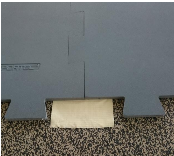
Verwendung eines doppelseitigen Klebebands
