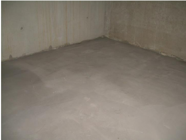
Glatter, geeigneter Untergrund aus Betonestrich
