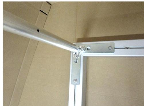
Im nächsten Montageschritt am offenen Ende jedes Bodenholms 2 Stck. Einsteckmuttern 20 mm, Gewinde M6 in die Nut einschieben. Dann 2 Stck. Unterlegscheiben Ø 7,4 mm, DIN 9021 auf 2 Stck. Sicherungs-Zylinderschrauben M6 x 20mm, DIN 912 stecken. Jeden Netzbügel mit den Sicherungs-Zylinderschrauben lose an den Einsteckmuttern befestigen (siehe Fotos unten).
