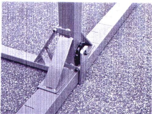
Ständerteil auf Fusschwelle setzen, so dass der Klemmhebel mit seiner Nase unter die Fuss-Schwelle greift.
